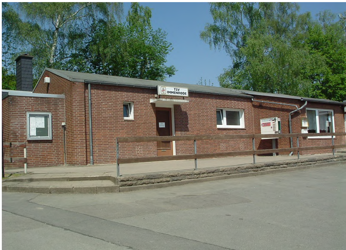
Abb. 1: Blick auf das SJH in Richtung NO
